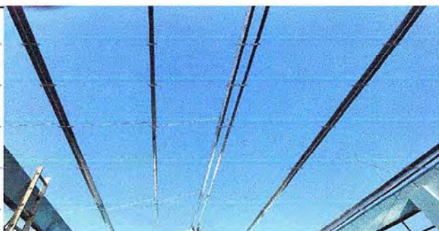
Foto 3: Aquí se aprecia la colocación de las costaneras galvanizadas, totalmente nuevas
