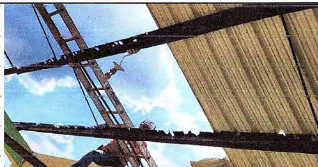
Foto 1: En esta fotografía se puede observar el procedimiento de quitar la cubierta de lámina
