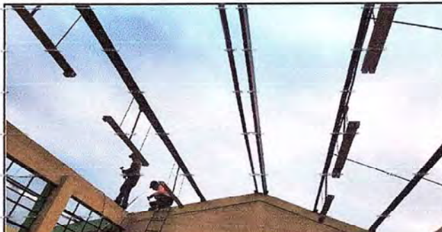
Foto 2: En esta fotografía se aprecia el procedimiento de quitar las costaneras inservibles
