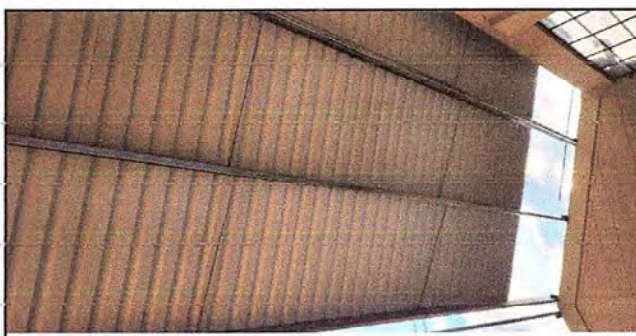
Foto 4: En esta imagen se observa la colocación de cubierta de lámina troquelada calibre 26
